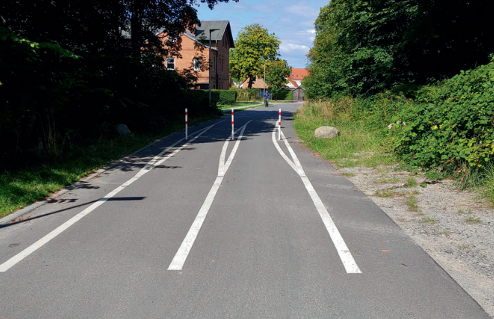
Bild 28: Längssperre in Form von Sperrpfosten mit deutlicher, frühzeitiger Markierung (Foto: ©Tim Birkholz/AGFK MV)
