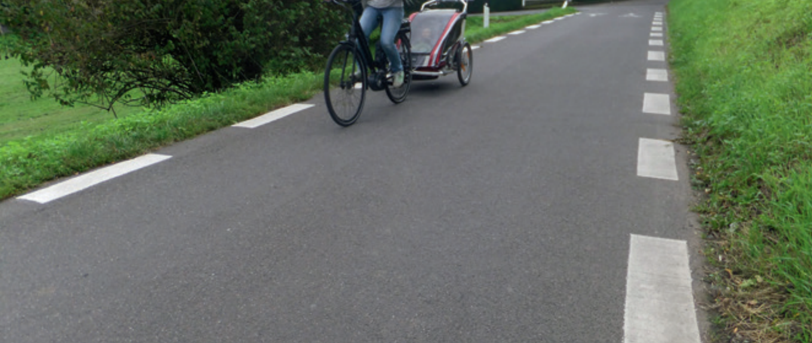
Bild 8: Kennzeichnung einer Fahrradstraße außerorts mit unterbrochener Breitstrichmarkierung (Foto: ©Thiemo Graf/Innovative Städte)
