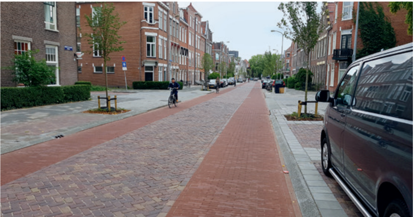
Bild 31: Diese Fahrradstraße in Utrecht ist mit rotem Pflaster ausgebaut. Gut erkennbar sind die beiden Fahrstreifen für den Radverkehr, die einen hohen Fahrkomfort ermöglichen. (Foto: ©Thiemo Graf/Innovative Städte)
