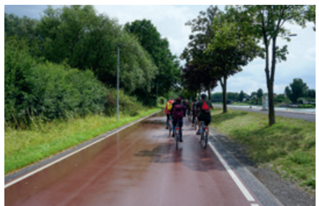
Bild 9: Fahrradstraßen mit flächiger Roteinfärbung innerhalb eines bebauten Gebiets (links) und außerhalb mit Fahrbahnrandmarkierung (rechts). (Fotos: ©Thiemo Graf/Innovative Städte)
