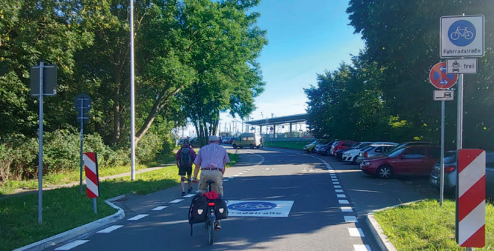
Bild 20: Tor-Wirkung am Beginn einer Fahrradstraße durch vorgezogene Seitenbereiche (Foto: ©Tim Birkholz/AGFK MV)
