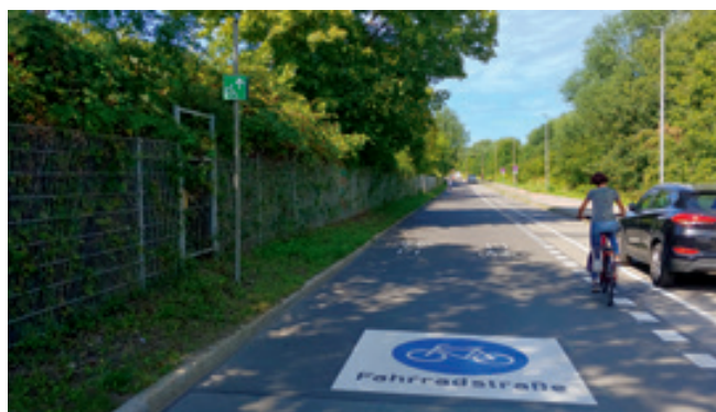
Bild 13: Zu Längsparkständen ist ein Sicherheitstrennstreifen von 0,75 m vorzusehen. Zudem sollte Kfz-Parken nur einseitig und in Form von Längsparkständen angeordnet werden. (Foto: ©Tim Birkholz/AGFK MV)
